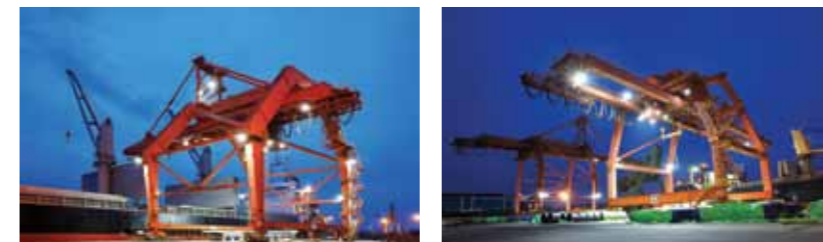
공장, 산업 현장, 상업시설, 옥외시설 등
